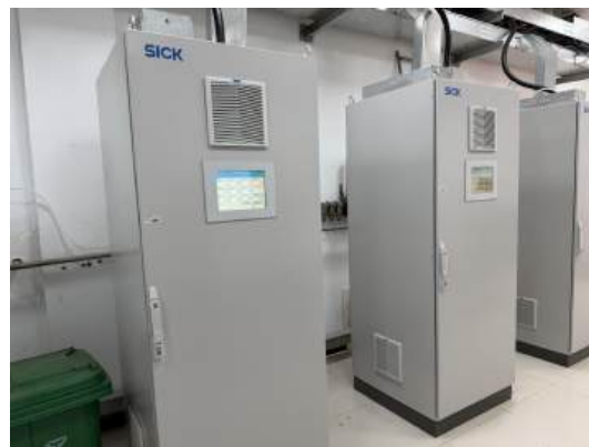
7#炉、8#炉烟气连续监测设备
