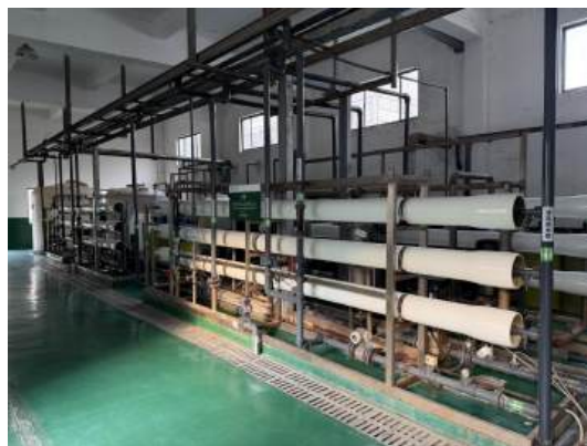
老厂区渗滤液处理站膜处理单元
