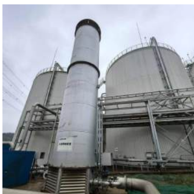
渗滤液处理站沼气燃烧系统
