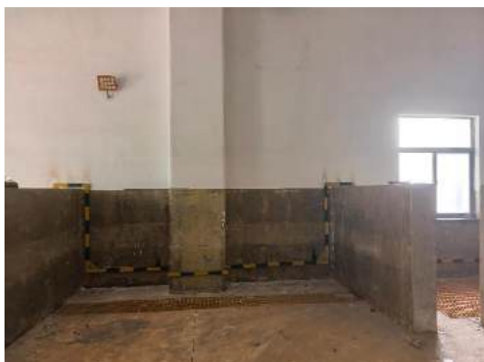
危废暂存间内部分区隔断及导流沟
