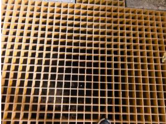
危废暂存间废液收集池
