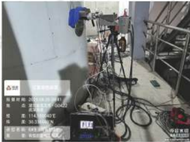
◎6#生活垃圾焚烧炉
