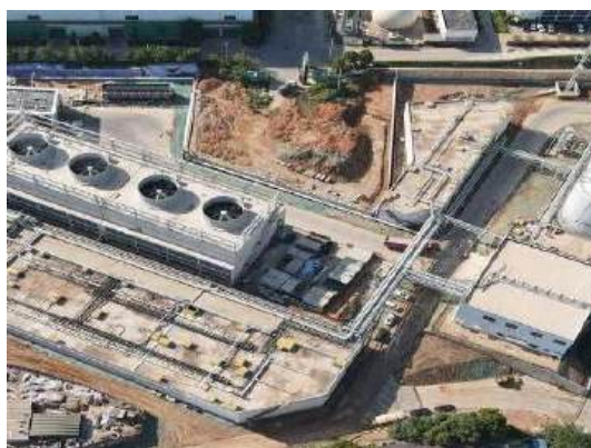
渗滤液处理站全景图
