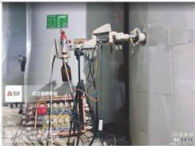
◎5#生活垃圾焚烧炉
