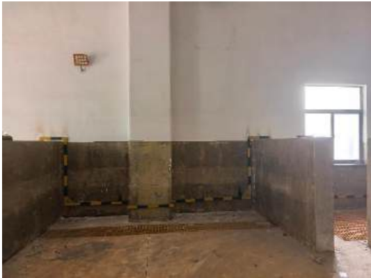
危废暂存间内部分区隔断及导流沟
