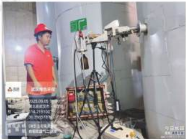
◎5#生活垃圾焚烧炉
