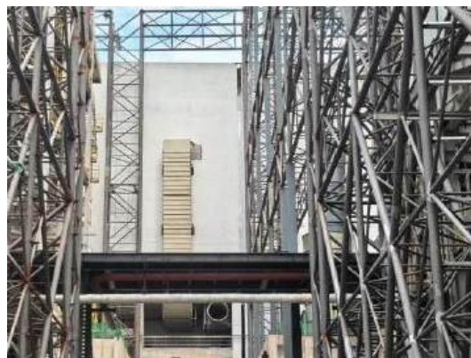
事故状态下垃圾库除臭排气筒
