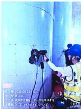
◎2 6#生活垃圾焚烧炉
