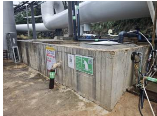
综合水池污水排放口
