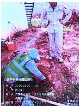
■2 渗滤液处理站附近
