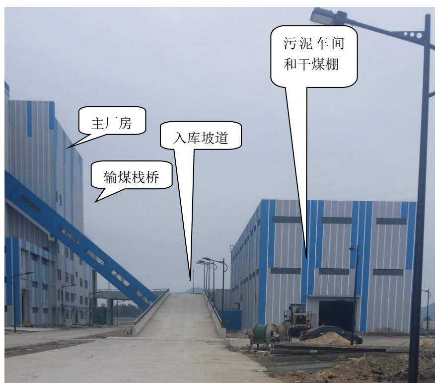
主厂房、垃圾入库坡道、污泥干化车间和干煤棚（全封闭）
