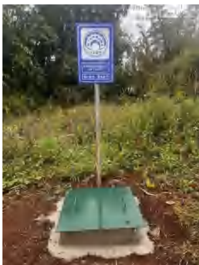
3#地下水监测井
