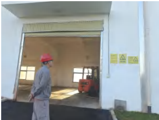
危险废物暂存间
