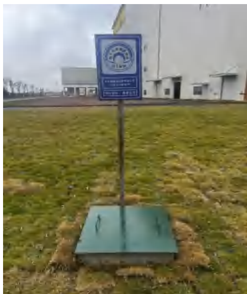
1#地下水监测井
