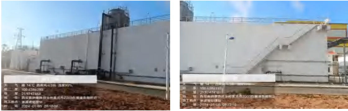
渗滤液处理站（内含工业废水处理站）
