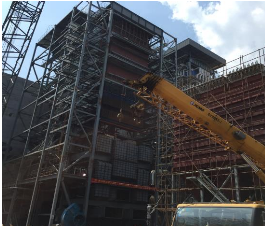
二期在建锅炉项目
