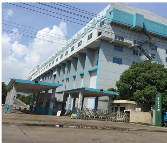
垃圾运输通道
